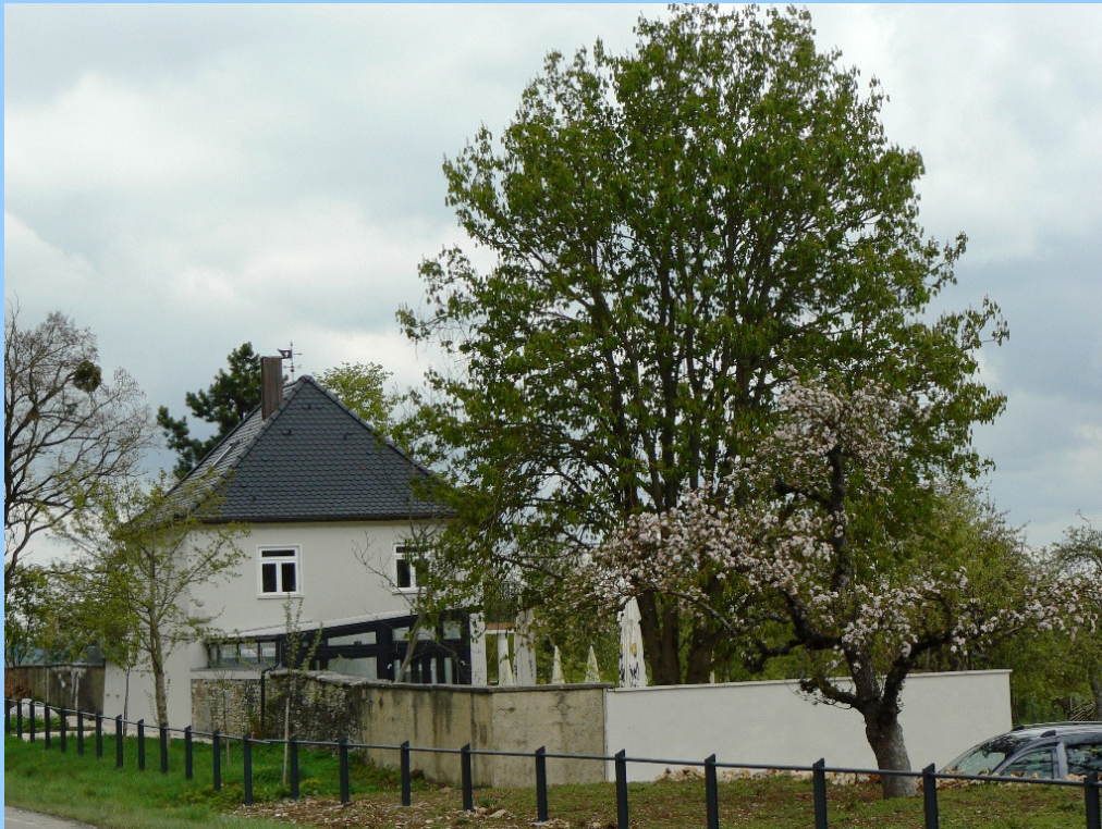
D'Villa, ehemaliges Amtshaus, wahrscheinlich Straßenposten der Scheibenstraße
